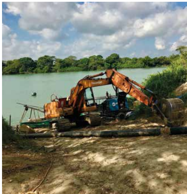
Figura 8.2: Sitio industrial de extracción de sedimentos en la cuenca del río Usumacinta. © E. Kauffer, abril 2018.
