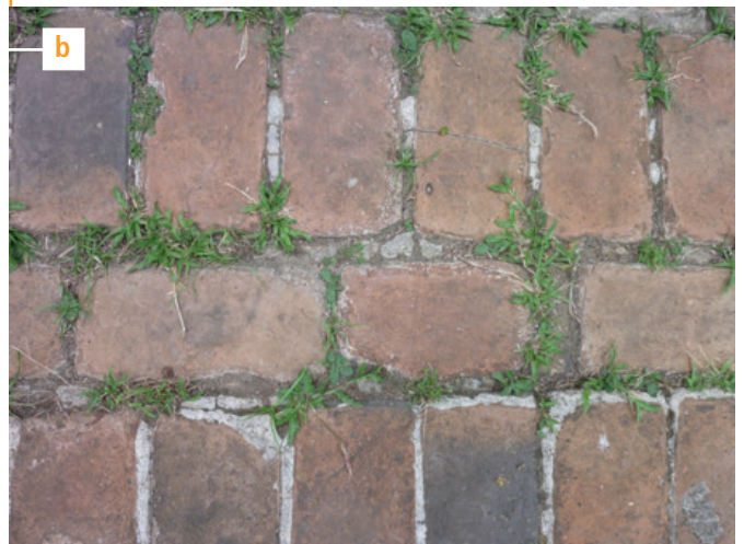
Figure 10.5 b : Chemin de briques cuites au sein du ranch San Roman, Palizada, Campeche, Mexique. © D. Levacher
